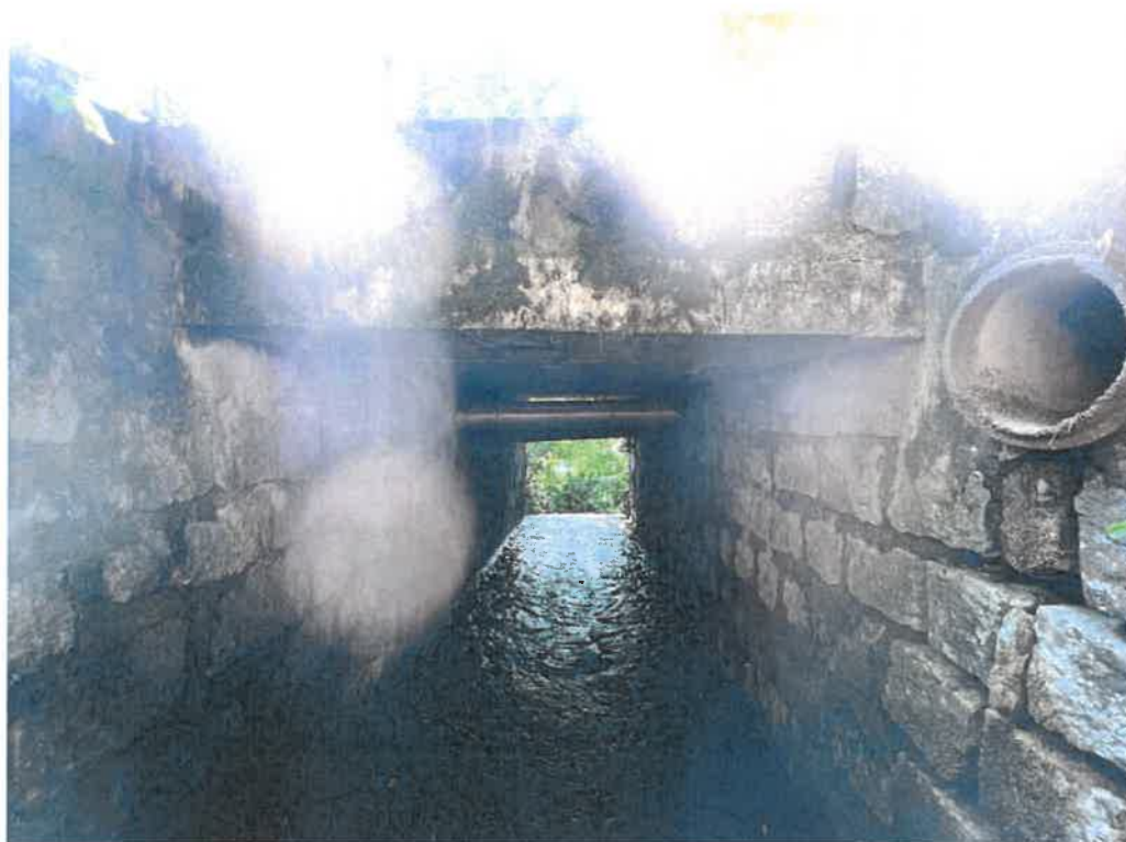
Foto no. 02 – Dettaglio condotte appese
